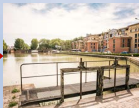
En 1973, l'aménagement du pont autoroutier sur le site historique du port de l'Embouchure entraîne la disparition de l'écluse, remplacée par un simple épanchoir.
