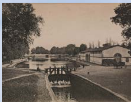
C'est ici que furent posées les premières pierres du canal du Midi le 7 novembre 1667. Cette écluse devait illustrer la vocation portuaire de Toulouse et son lien avec la Garonne.
