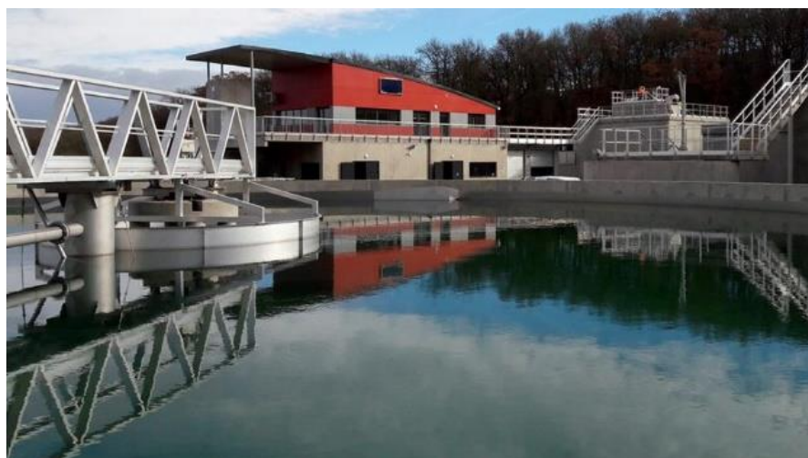
Figure 41 : Nouvelle station d'épuration de la Salvetat Saint Gilles construite et gérée par Réseau 31
