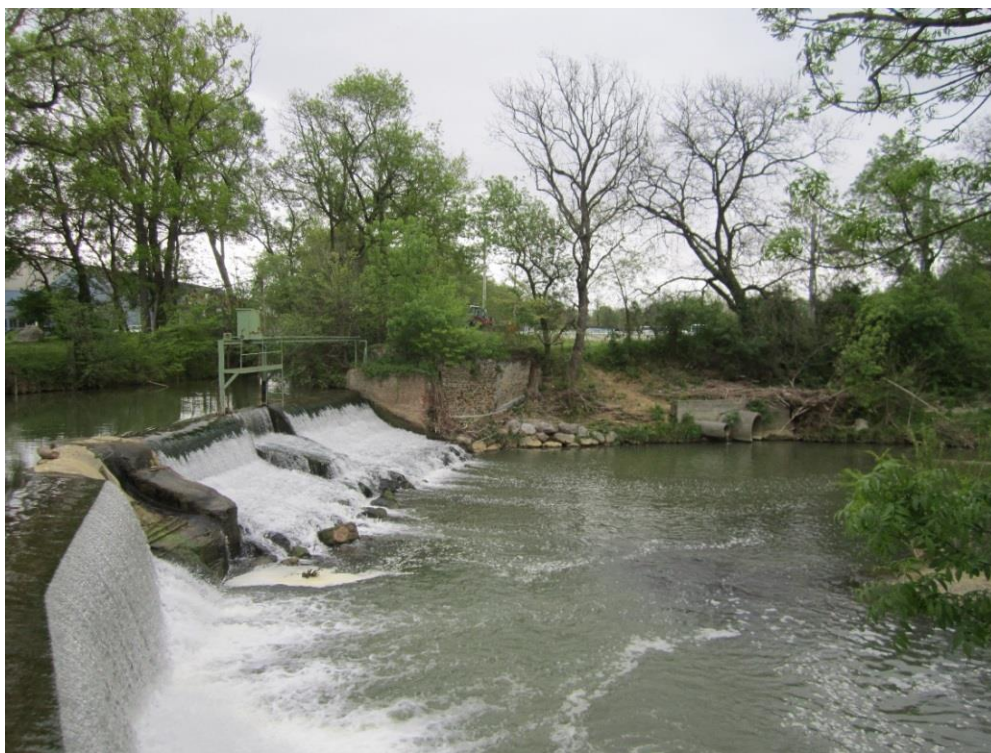
Figure 7 : barrage sur le Touch qui entrave la remontée des poisons et le transport des sédiments.
